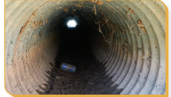
Inspeccione las tuberías subterráneas. Realice reparaciones (si es necesario) y remueva el sedimento y basura que se pueda recoger adentro.
